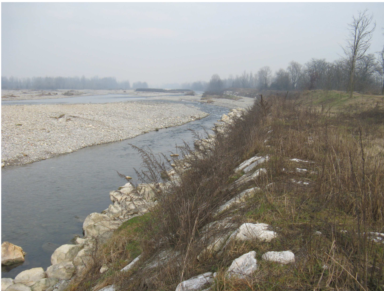
Fig.5 – Tratto della sponda sinistra del fiume Serio rettificata e protetta da opere di difesa
