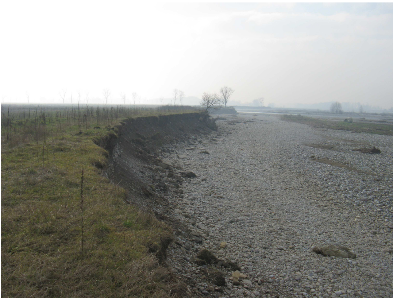
Fig.4 – Tratto in erosione della sponda sinistra del fiume Serio
