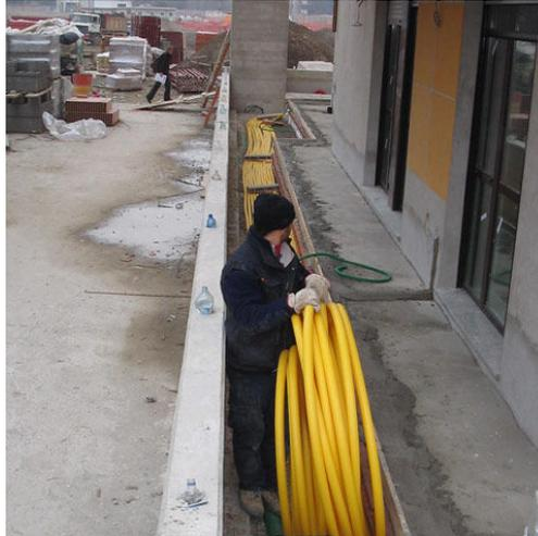
b) in polifora o cavidotto: manufatti costituiti da elementi tubolari continui, affiancati o termosaldati, per infillaggio di più servizi di rete;
